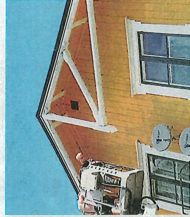
Renovering av snickarglädje från 1800-talet.
